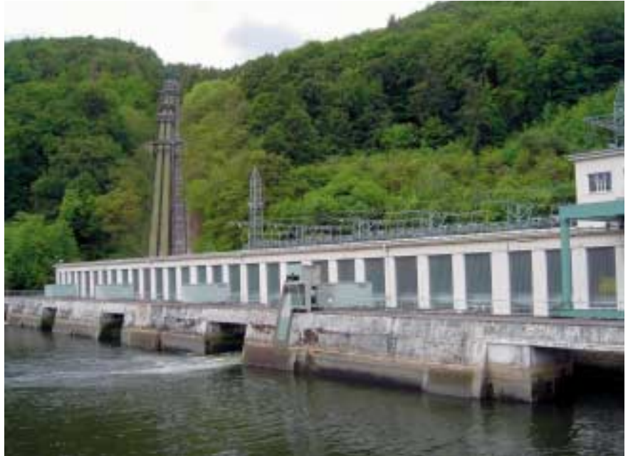
Das Krafthaus und die Druckrohrleitungen des bestehenden Pumpspeicherwerkes Waldeck I
