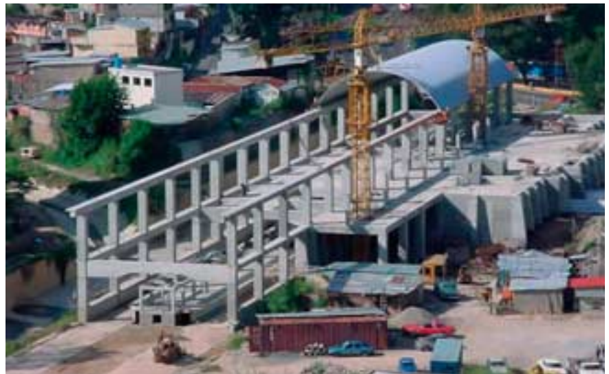
Station Los Teques in der Bauphase
