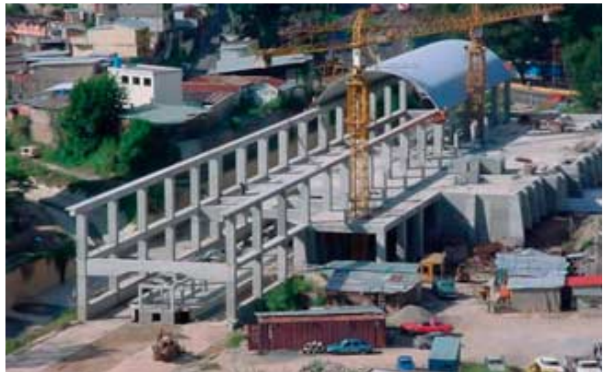
Station Los Teques in der Bauphase
