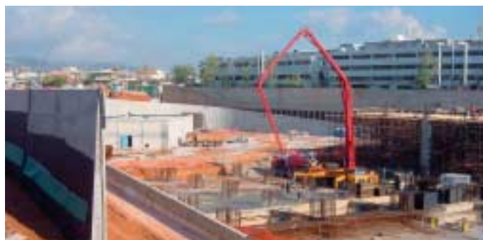
Das Depot Stavros in der Bauphase
