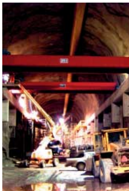
Bauzustand der Maschinenkaverne im September 2004
