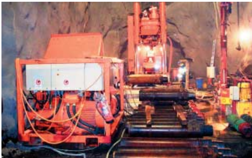
Raise-Bore-Maschine im Einsatz für die Herstellung der Druckschächte
