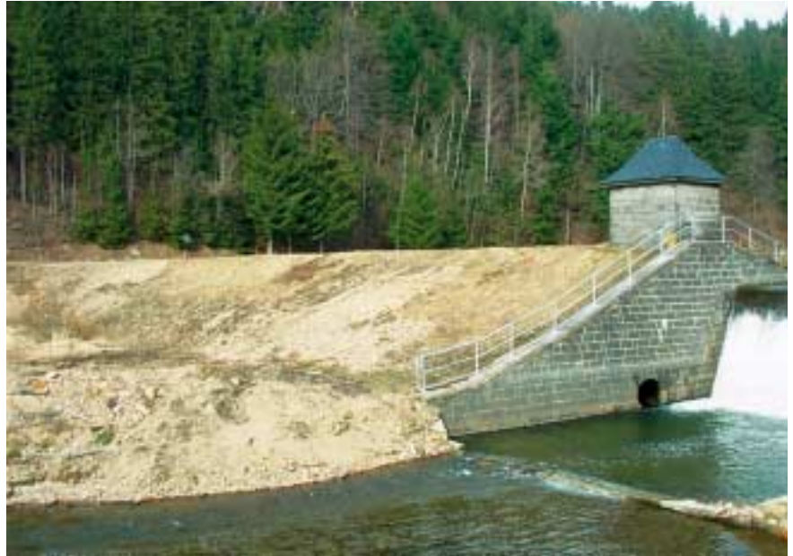
Die vorhandene Vorsperre der Talsperre Klingenberg mit Hochwasserentlastung
